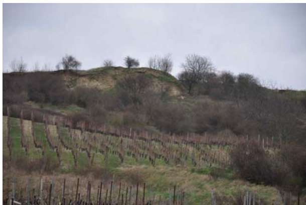
Bild 16: Abrisskante im oberen Bereich, Aufnahme vom 28.03.2010
