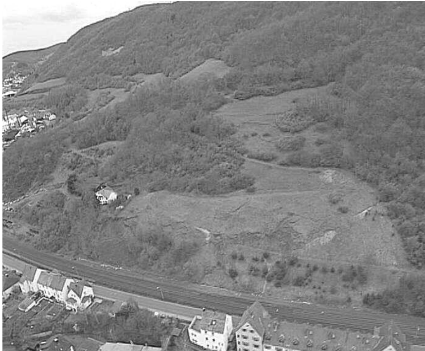
Abb. 1.8: Rutschareal Kirn mit der gefährdeten Bahnstrecke
