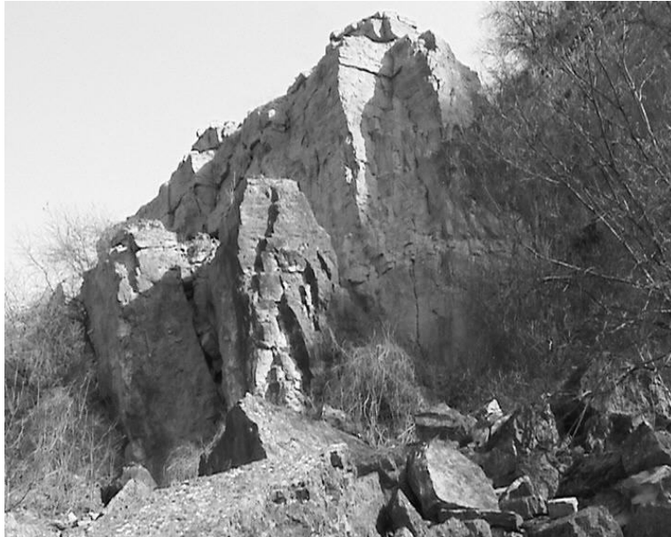
Abb. 1.1: Drift- und Fallbewegungen im Bereich einer aufgelassenen Steinbruchwand bei Temmels.
