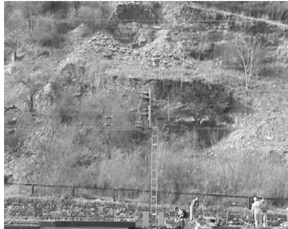
Abb. 1.3: Durch den Einsturz von Weinbergsmauern und nachrutschenden Bodenmassen gefährdete Bahnstrecke im Bahnhofsbereich Cochem. Die Schuttströme (Rutschungen) breiten sich nach unten und oben aus (Rechteck links: Ausschnitt Bild rechts)
