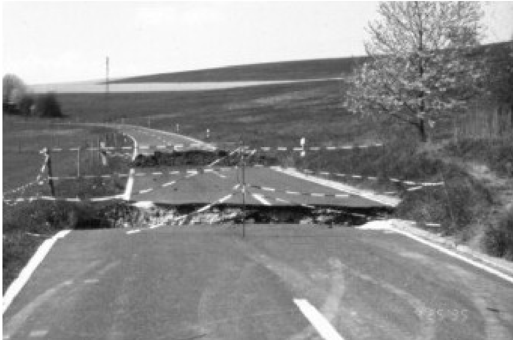
Abb. 3.5: Hangrutschung in sehr flachem Gelände in Ton-Schluffschichten (Tertiär) in Rheinhessen.
