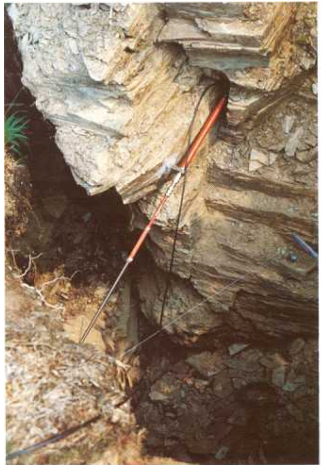
Eingebauter Fissurometer zwischen Massiv und Felsblock mit herkömmlicher Meßmethode
